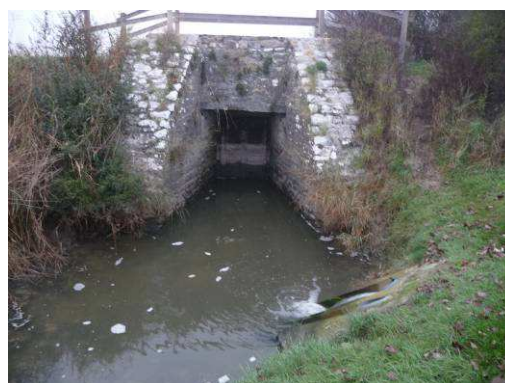
Figure 25 : Vue sur la porte à flot du Canal du Passevin (24/11/2011)
