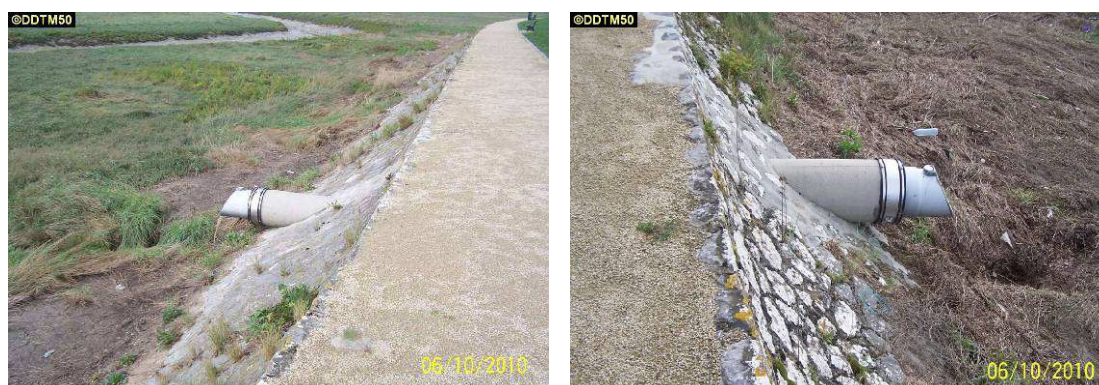
Figure 33 : Emissaires pluviaux débouchant dans le havre de Regnéville (Clichés de la DDTM50)
