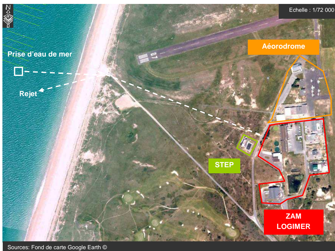
Figure 41 : Vue sur le rejet de la zone conchylicole de Bréville-sur-Mer
