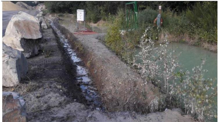
Le dispositif en place actuellement permet de collecter par un fossé périphérique au nord, les eaux des plateformes vers un premier bassin de décantation D1 puis par surverse vers un bassin de rétention et de régulation D2. En sortie de D2 les eaux sont canalisées vers le fossé de bords de RD 104. Les coordonnées du point de rejet sont en lambert 2 :
